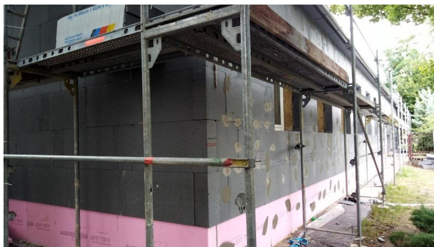
Kazánház és emeletes épület homlokzati hőszigetelése
