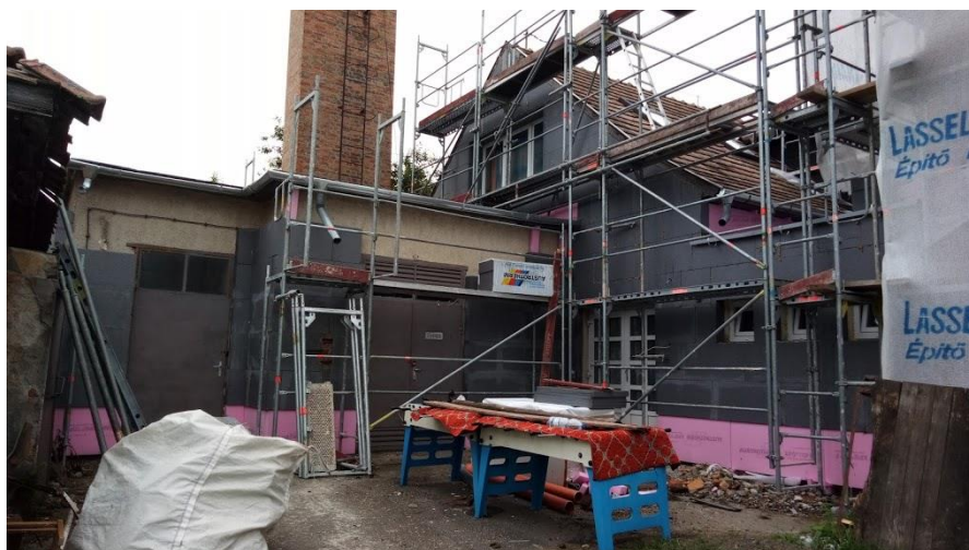
Kazánház és emeletes épület homlokzati hőszigetelése
